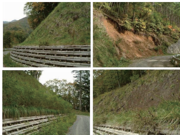
写真-3 緑化が上手くいかないのり面 裸地化したのり面（右上、右下） 外来緑化植物に被圧されたのり面（左上、左下）
