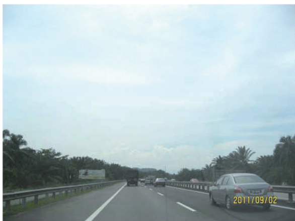
写真5 マレーシアの高速道路（マレーシア・ペラ州）
