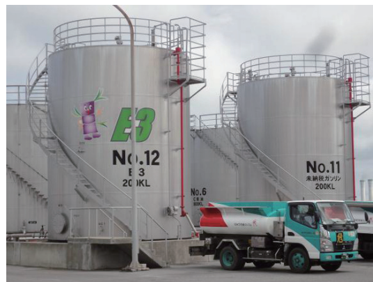
写真3 製造されたE3燃料のタンクとタンクローリー。
