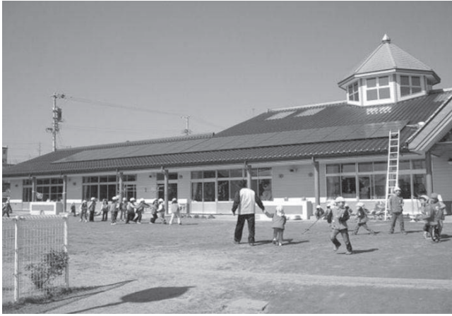
写真 2 長野県飯田市の保育園に設置された太陽電池パネル
